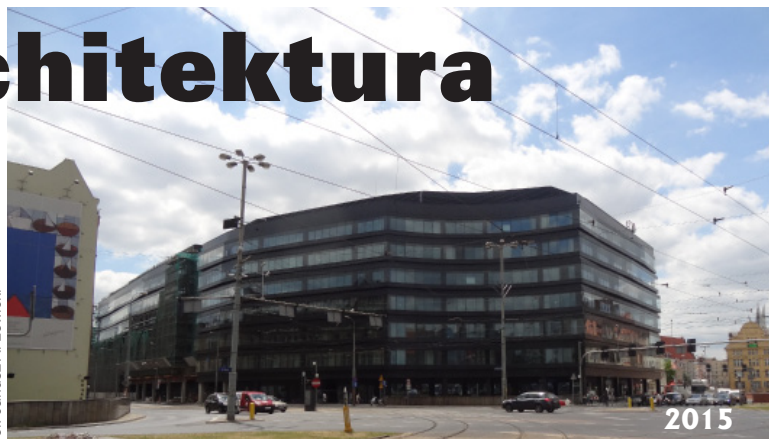
Biurowiec Dominikański w centrum Wrocławia Autorzy: architekci Przemysław Łukasik i Łukasz Zapała
