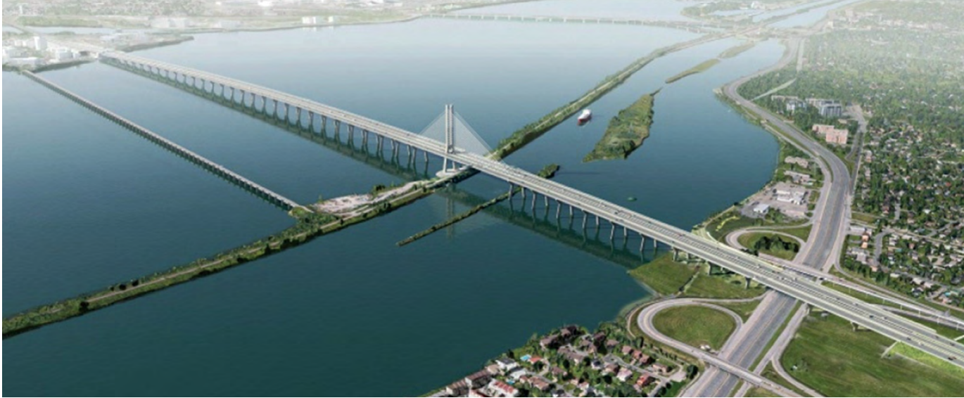
Nowy most Champlain w Montrealu przez rzekę św. Wawrzyńca – obecnie w budowie
